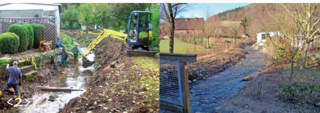
handen war, konnte auf die Sicherung mit Wasserbausteinen verzichtet werden. Das Bachbett wurde aufgeweitet und die Uferbereiche flach gestaltet. Abschließend wurde eine Hecke mit einheimischen Sträuchern gepflanzt. Jetzt trennen Haselnuss, Hartriegel, Schneeball & Co das Ufer vom Gartenbereich.
