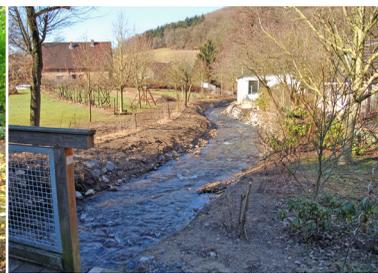
handen war, konnte auf die Sicherung mit Wasserbausteinen verzichtet werden. Das Bachbett wurde aufgeweitet und die Uferbereiche flach gestaltet. Abschließend wurde eine Hecke mit einheimischen Sträuchern gepflanzt. Jetzt trennen Haselnuss, Hartriegel, Schneeball & Co das Ufer vom Gartenbereich.
