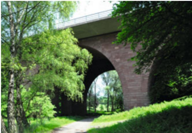
heute in Nutzung und halten nach wie vor auch dem immensen Verkehrsaufkommen unserer Tage stand. So auch die knapp 160 Meter lange Überquerung des Finnebaches im Grenzgebiet zwischen Vlotho-Exter und der Kreisstadt Herford. Auf zwei parallelen Bauwerken mit einer Gesamtbreite von 38 Metern, überspannen je fünf Gewölbe den Wasserlauf und den benachbarten Radweg.
