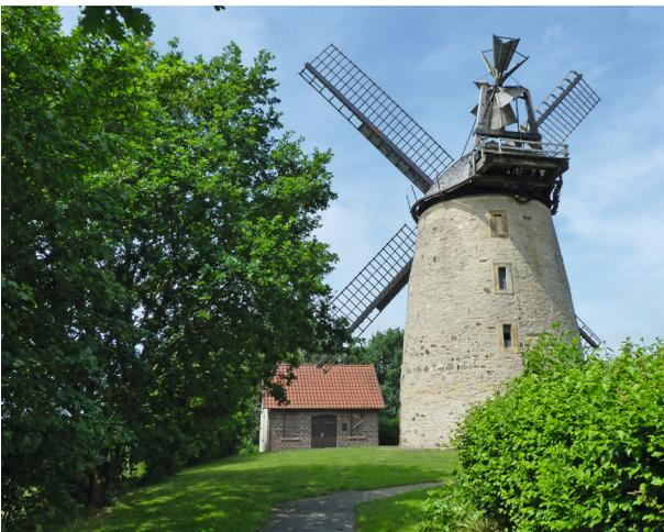
Rund 430 Haushalte waren so genannte Mahlgäste der Liesbergmühle, auch „Königsmühle“ genannt, die bei gutem Wind 7 bis 8 Zentner Mehl pro Tag schaffte. Die Mahlwerke mit den großen, hölzernen Zahnrädern waren bis 1960 in Betrieb. Das große Flügelrad und die Windrose der Mühle sind intakt und verleihen ihr das heute noch imposante Aussehen.
