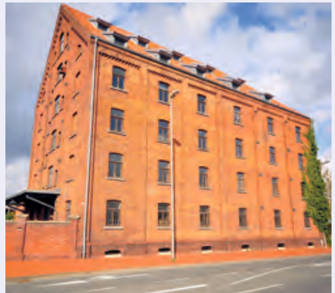
Tabakspeicher in Bünde
