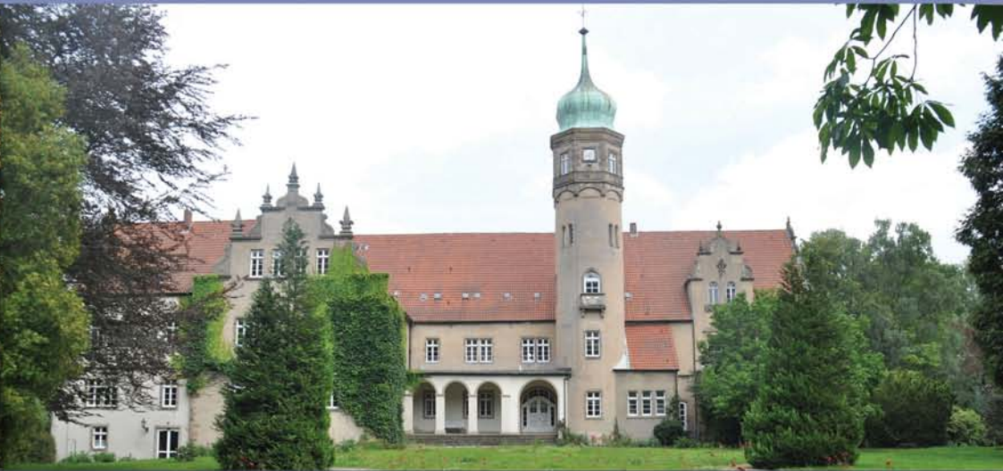
Südfassade der Ulenburg
