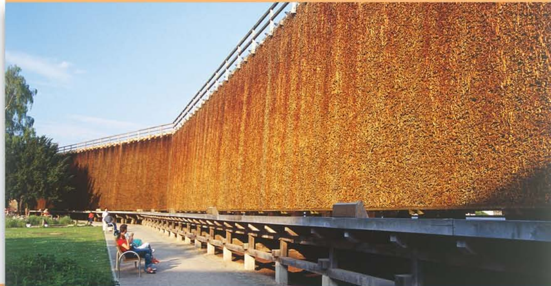
Blick auf das Gradierwerk
