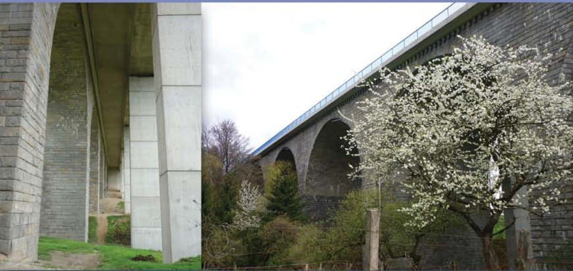
Neue und alte Bauteile der Talbrücke Steinegge
