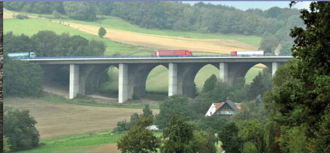
Ausblick auf die Talbrücke Steinegge
